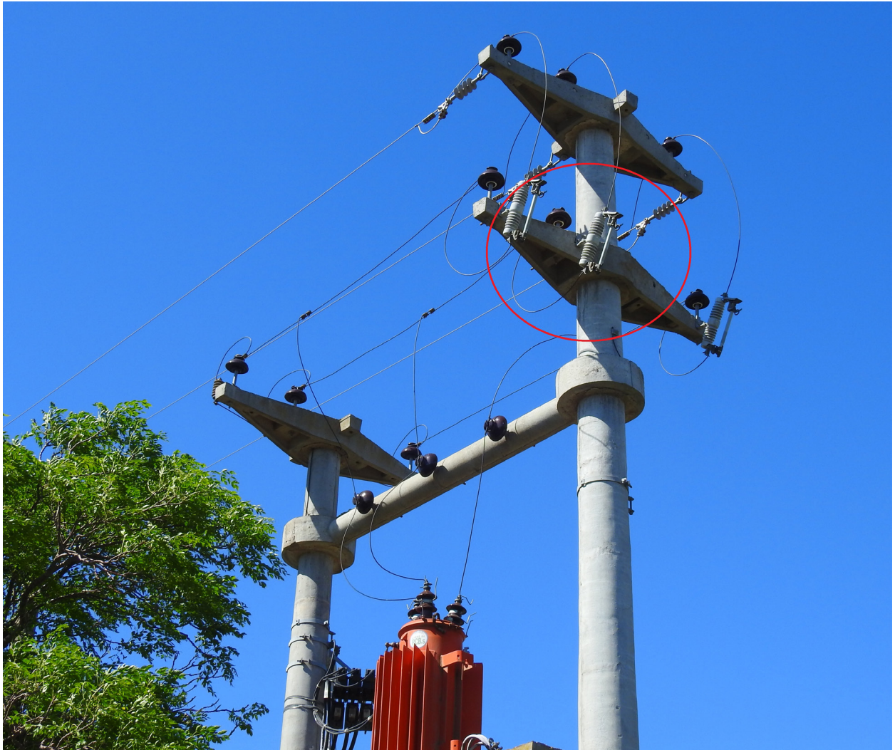
Figura 2: Transformador de energía eléctrica en el cual encontré un nido de Estornino Pinto ( Sturnus vulgaris ) el 6 de noviembre de 2020 a 5 km de la ciudad de Oncativo, Córdoba, Argentina. El círculo rojo indica la zona en la que bajaban los adultos con alimento en el pico, donde se encontraría el nido. Fotografía: Merlo F.
